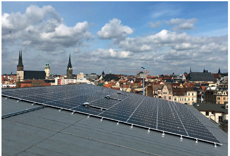
Als ergänzende Energie-Effizienzmaßnahme wurde auf dem Dach des Standorts St. Elisabeth eine Photovoltaik-Anlage installiert.
