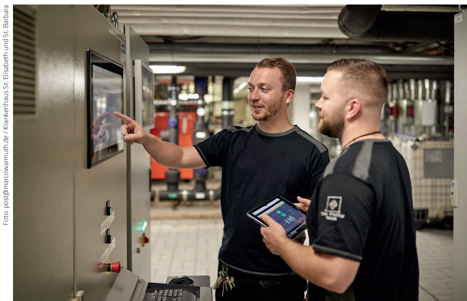
Im Rahmen der Sanierung wurde die Gebäudeleittechnik erneuert; ein übergeordnetes integriertes Automatisierungssystem wurde installiert.
